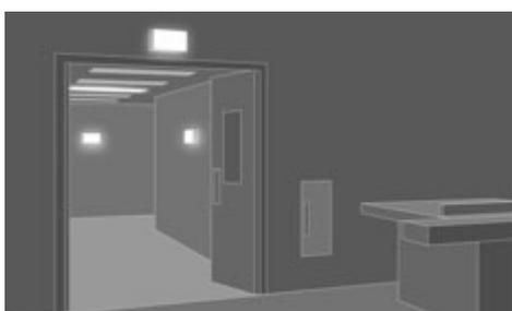
**Sicherheitsleuchten** erleichtern die Orientierung bei einem Netzausfall und sorgen dafür, dass Gebäude im Ernstfall möglichst schnell und gefahrlos verlassen werden können. Sie müssen im Notfall unabhängig vom Stromnetz betrieben werden, zum Beispiel mit Batterien, Akkus oder einem Notstromsystem.
