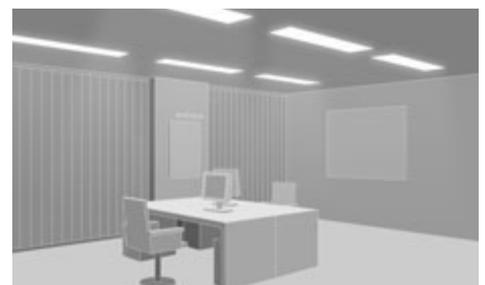
**Deckeneinbauleuchten** werden bündig in die Decke eingelassen. So wirkt nur noch das Licht, der Leuchtenkörper tritt in den Hintergrund. In Büroräumen werden Deckeneinbauleuchten meist parallel zur Fensterfront eingebaut. Für eine gute Entblendung sorgt die richtige Rastertechnologie.
