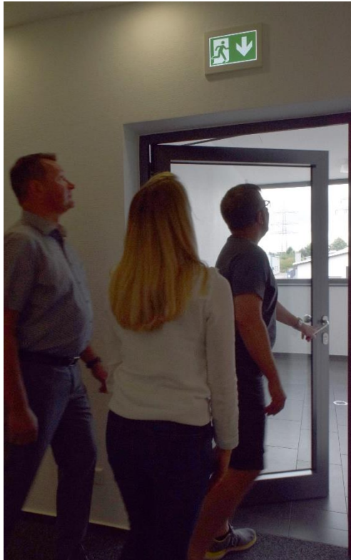
Bild 1 Etablierte Kennzeichnung einer Tür im Verlauf eines Flucht- und Rettungsweges. Die flüchtenden Personen haben die Aussage der Pfeilrichtung über der Tür eindeutig verstanden und verhalten sich richtig. Quelle: Inotec
